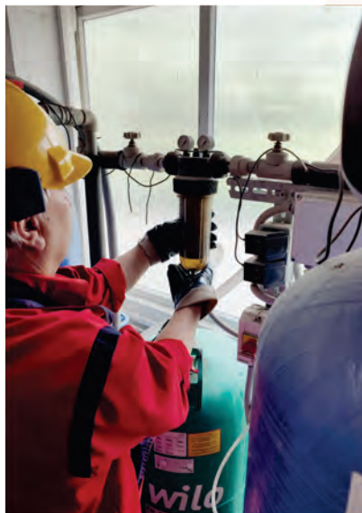
Подмяна на замърсен филтър на омокотителна станция
