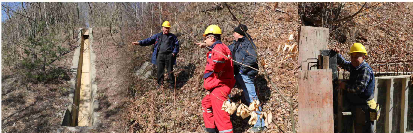
Инж. Стоил Трошанов - ръководител на цех „Водно-отпадно стопанство, екстракция и електролиза и пречиствателни станции“, и инж. Иван Смилянов от отдел „Строителство“ провериха проводимостта на съоръженията на Източно насипище и изпълнението на новия проект
